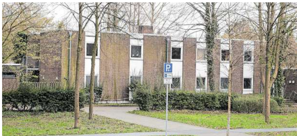
Vor zweieinhalb Jahren sind die letzten Bewohner aus dem Wohnheim für behinderte Menschen ausgezogen. Seitdem steht das Haus leer, nun soll es abgerissen werden. FOTO: ROLAND SCHEITZ
